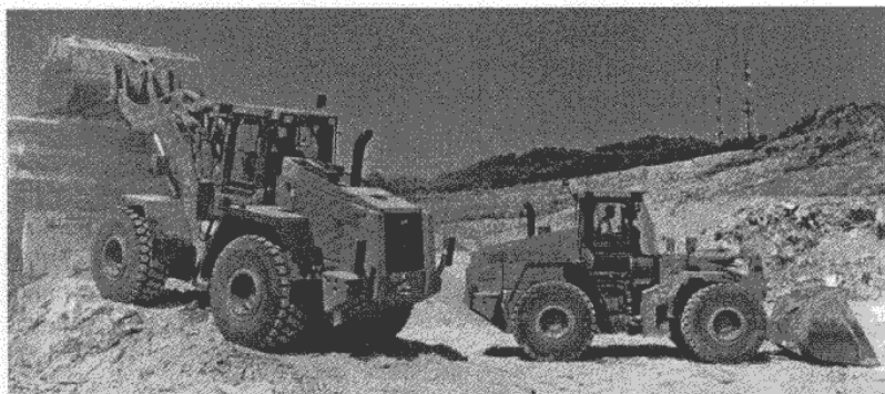
Foto 3.- Las dos cargadoras CASE 821 C trabajan 10 horas ininterrumpidas en el transporte de derribos y de áridos finales.
